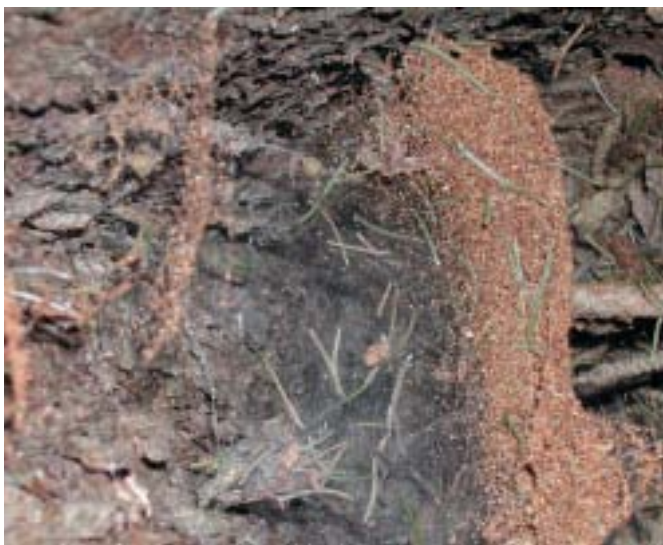
Abbildung 1: Borkenkäferbefall wird am ausgeworfenen Bohrmehl sichtbar
