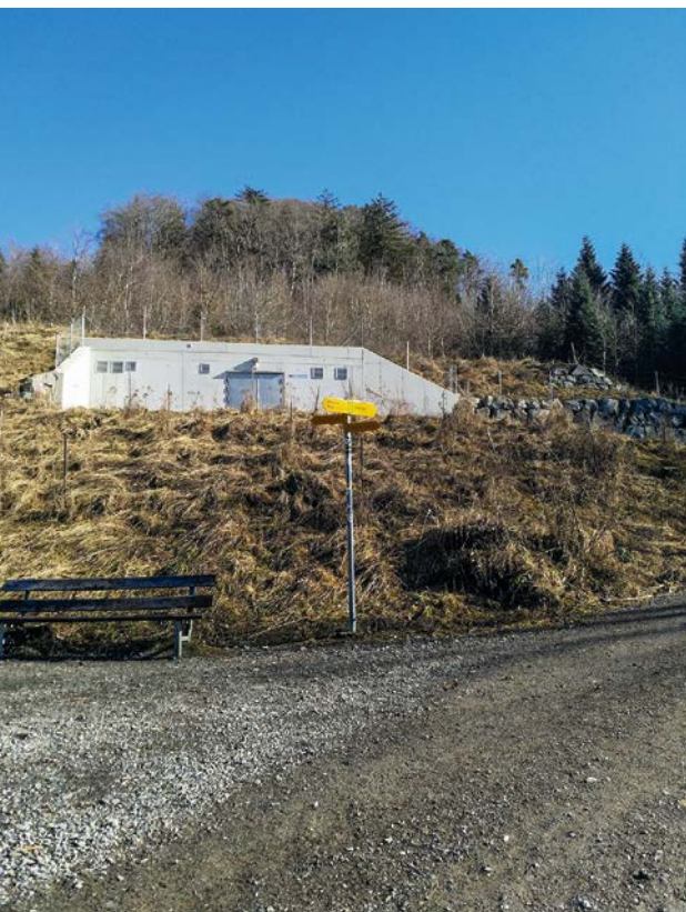
Neues Trinkwasserreservoir am Gurten, Gemeinde Kőniz.
