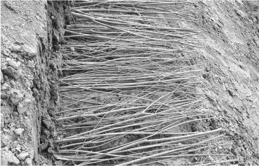
Abb. 3: Einbau einer Buschlage. Fertig ausgelegte lebende Äste von Weiden (*Salix spec.*) kurz vor dem Abdecken mit Boden. Maßnahme zur Sicherung einer Steilböschung auf der Deponie Blumentobel, Lkr. Esslingen (Foto: König).
