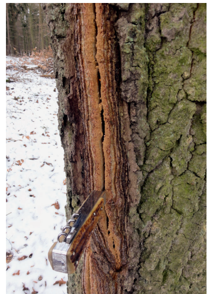
Abb. 19: Frostrisse an einer starken Zerr-Eiche im Revier Prenzlau
