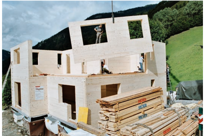
Abbildung 2: Das Konzept des 100% Naturhausbaus mit gedübelten Platten ohne Klebstoff und Nägel (Firma Thoma, Österreich).
