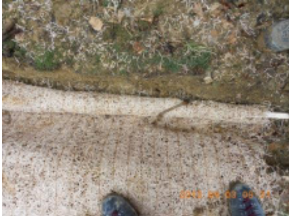
Abbildung 9: Bergseitige Verankerung des Vlieses
