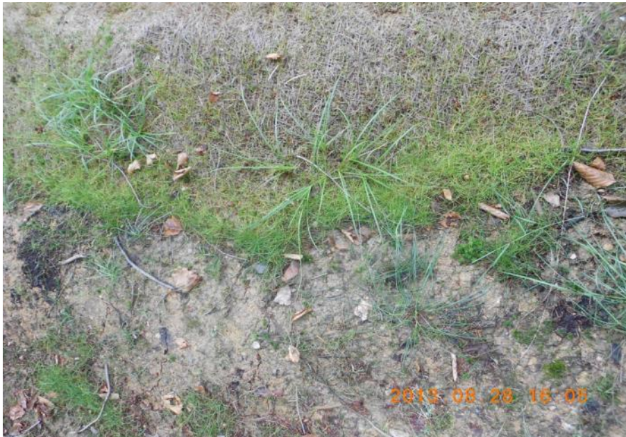
Abbildung 36: Bergseitige Verankerung der Vliese, östlicher Teil.
