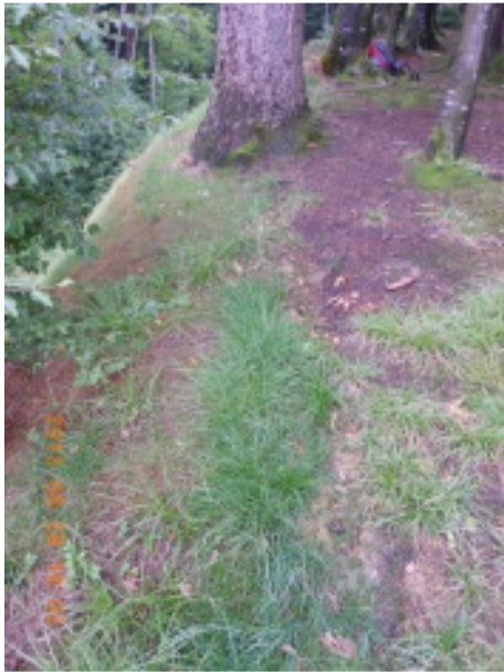
Abbildung 35: Bergseitige Verankerung der Vliese, westlicher Teil.
