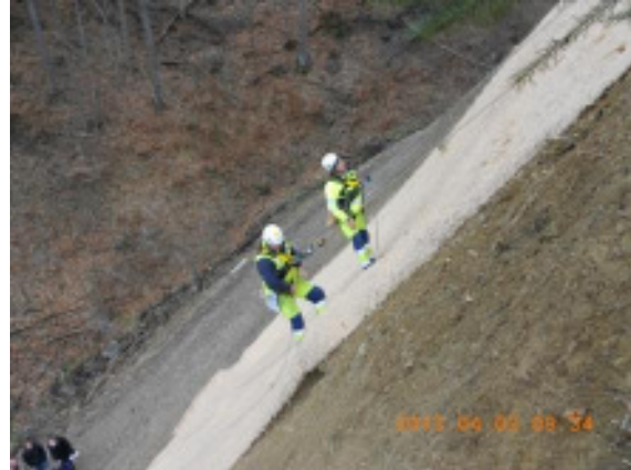
Abbildung 10: Vernagelung des Vlieses am Hang
