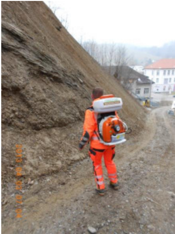
Abbildung 7: Einbringen der Samen unter das Vlies
