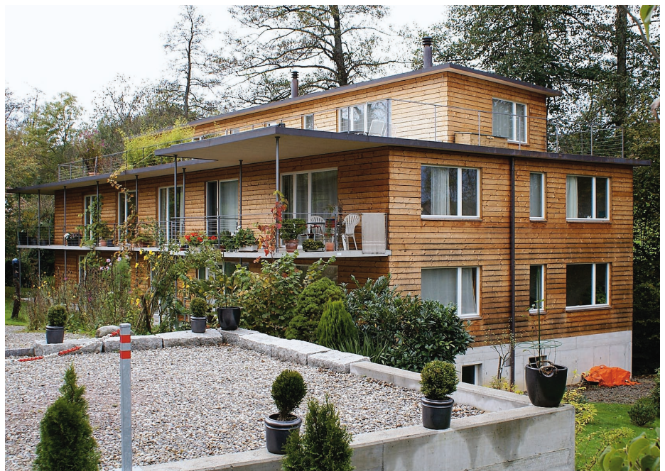
Abbildung 2: Haus mit Fassade aus thermisch vergütetem Holz, zwei Jahre nach Erstellung.
