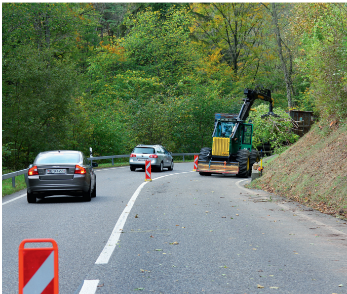
Holzereiarbeiten an einer Kantonsstrasse müssen frühzeitig gemeldet werden. Die korrekte Absicherung einer solchen Strasse erfordert Know-how und passendes Material.
