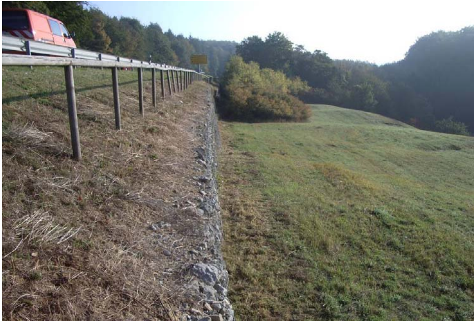
Abb. 4-16: Gegenüber der Einmündung der Kreisstraße K3936 Breitenbronn ist zur Sicherung der Böschung bei der Erweiterung der Bundesstraße eine Gabionenwand errichtet worden. Auf einer Länge von über 100m ist diese Verbauung auch mit seiner Höhe für Wildtiere als Wildrampe gut nutzbar. Die Gabionen sind daher vollständig in den Leitzaun integriert worden. Sie bieten versehentlich über die Einmündung der Kreisstraße K3936 eingewechselten Tieren eine direkte Möglichkeit, die Straße wieder zu verlassen. Dies war bisher aber noch nicht notwendig.
