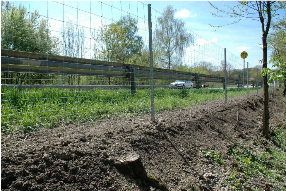
Abb. 2-7: Ein wildsicherer Leitzaun lenkt die Tiere zu den Wechselbereichen und verhindert unbeabsichtigtes Auftauchen von Wildtieren auf der Fahrbahn. Teilweise ist der Zaun dachssicher eingegraben.
