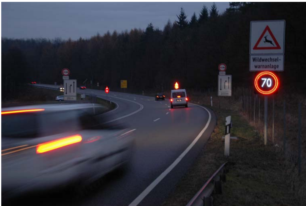
Abb. 2-8: Die ausgelösten LED-Lichtsignaltafeln an der Anlage 2 Breitenbronn in Fahrtrichtung Aglasterhausen während der Nachtstunden.
