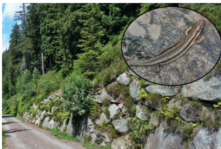
Südexponierte, mit Felsblöcken oder Steinkörben stabilisierte Böschungen bieten Reptilien wie der Waldeidechse Sonnenplätze und Unterschlupf.
