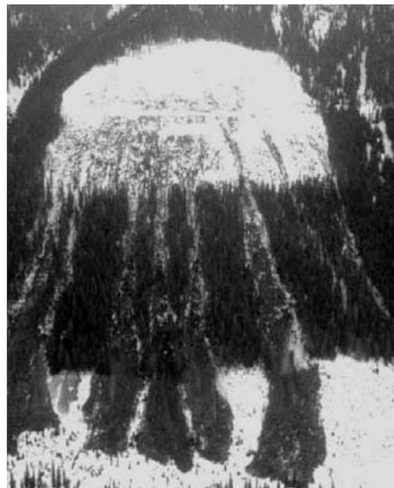
Abb. 4. Am Nagle Creek bei Mica Creek (B.C., Kanada) ist in einer Kahlschlagfläche am 14. März 1996 eine 500 m breite Lawine angebrochen, die im darunterliegenden Bestand rund 12,5 ha Wald zerstörte. Die Anrissmächtigkeit variierte zwischen 0,8 und 1,2 m bei einer Hangneigung von 33–42°. Die Lawinenkubatur betrug rund 200 000 m<sup>3</sup> und die Länge der Fliessstrecke im Freiland erstreckte sich über maximal 500 m (WEIR 2002).
