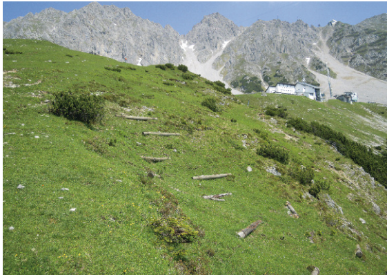
Abbildung 9: Piloten – einfache Erosionssicherung mit quergelegten und -fixierten Bäumen. Dadurch wird die Erosion vermindert, Feinmaterial akkumuliert und das Ankommen von Vegetation (auch von Pionierhölzern) erleichtert.
