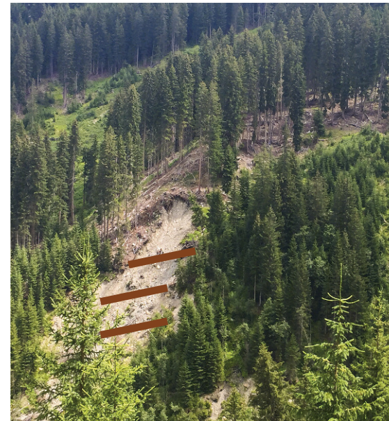
Abbildung 14: Istalanzbach – Beispiel einer gut gesetzten Räumungsmaßnahme auf einem Rutschhang (orographisch rechtsufrig im Mittellauf).
