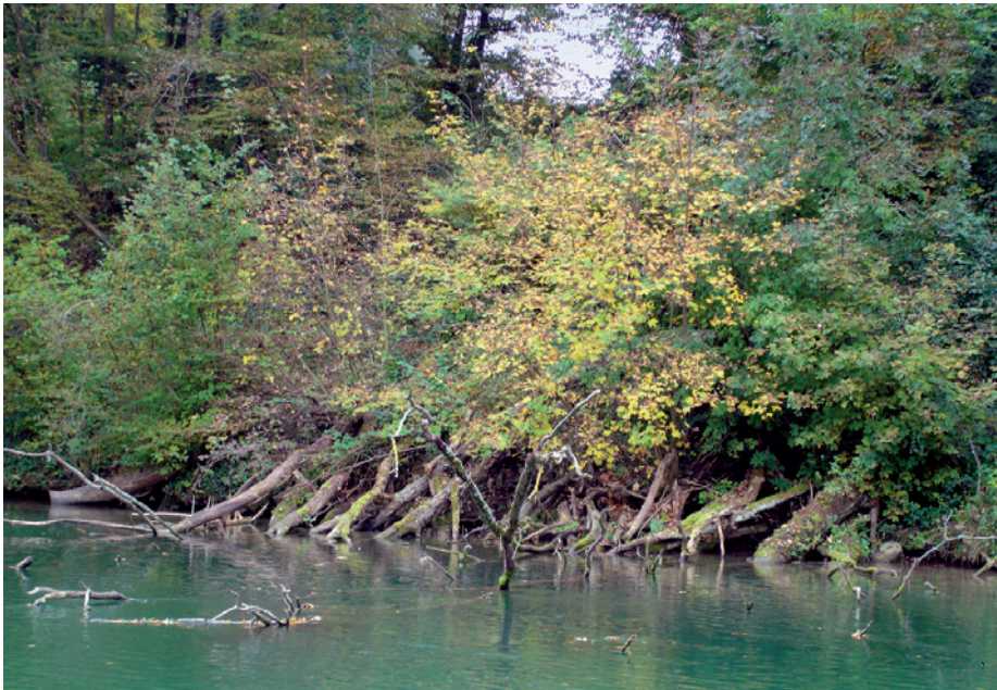
Mit dem Anlegen der Raubäume wird gleichzeitig auch die Verjüngung der vielfach überalterten Uferbestockungen eingeleitet. Nach wenigen Jahren gestaltet sich um die Raubäume eine üppige Vegetation, die das Wegschwemmen der Bäume zusätzlich verhindert.
