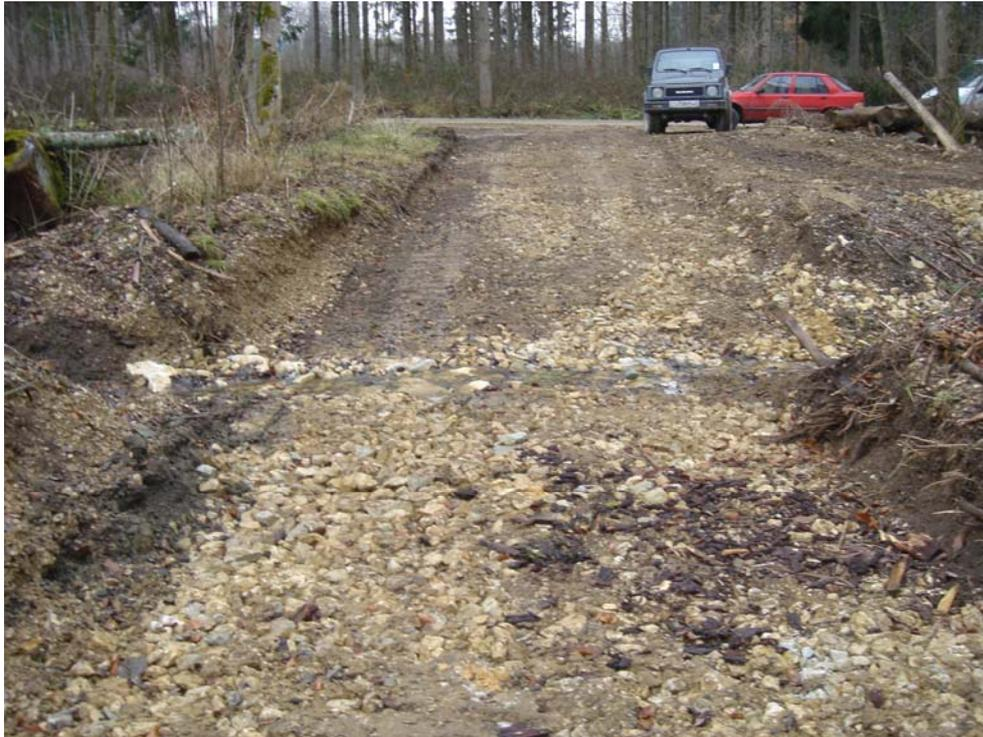
Nach Fertigstellung der Nacharbeiten: Weg führt beidseits mit flachem Gefälle zur Furt; 14.12.2005
