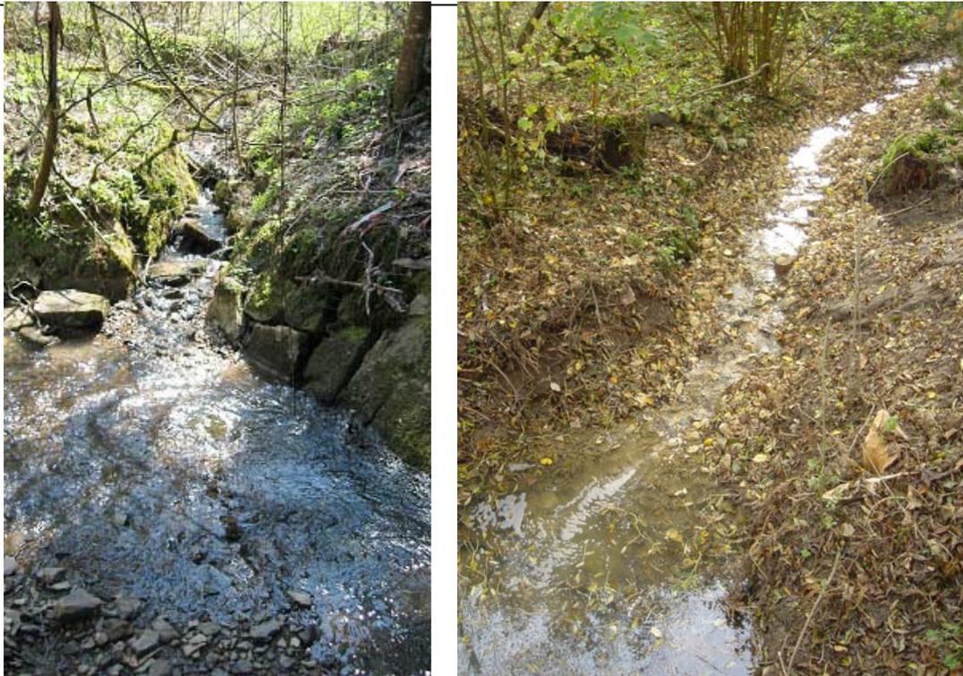
Vor der Maßnahme (links): durch Eintiefung des Hauptlaufs sind im Jakobsbrunnenbach Sohlenstufen entstanden, die für Fische und Kleinlebewesen unpassierbar waren; Aufnahmedatum: Juli 2005. Fertige Raue Rampe (rechts). Die Ufermauern im Einmündungsbereich wurden abgebaut; 21.10.2005
