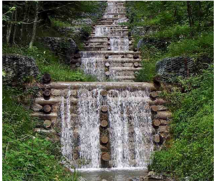
In voller Breite gut benetzte Sperre (Gasenzenbach, Gams SG)
