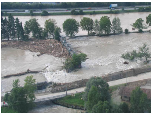
Abb.1: Verklausung am Wehr des Kraftwerkes Perlen/Buchrain, LU, im August 2005 (Foto: H Bucher).
