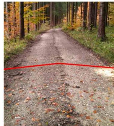
**Nachher:** Forstweg nach Abziehen des humosen Materials und Wiederherstellung eines Dachprofils zur seitlichen Wasserableitung (nach Schritt 2).
