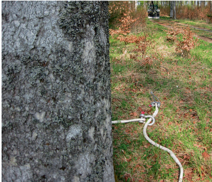
Schritt 1: Das Anschlagseil wird um den Stammfuß ausgelegt und mittels Schäkkel zu einer Schlinge verbunden. Der zweite Schäkkel stellt die Verbindung zum Windenseil her.
