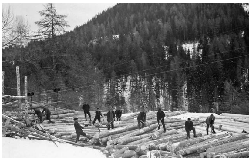
Entladestation einer Valtellina-Seilbahn in Giarsun: Arbeiter schälen Holz. Pro Tag wurden zwischen 80 bis 100 Festmeter Holz ins Tal gesieilt. Für viele Berggemeinden war der Holzverkauf lange Zeit eine wichtige Einnahmequelle.
