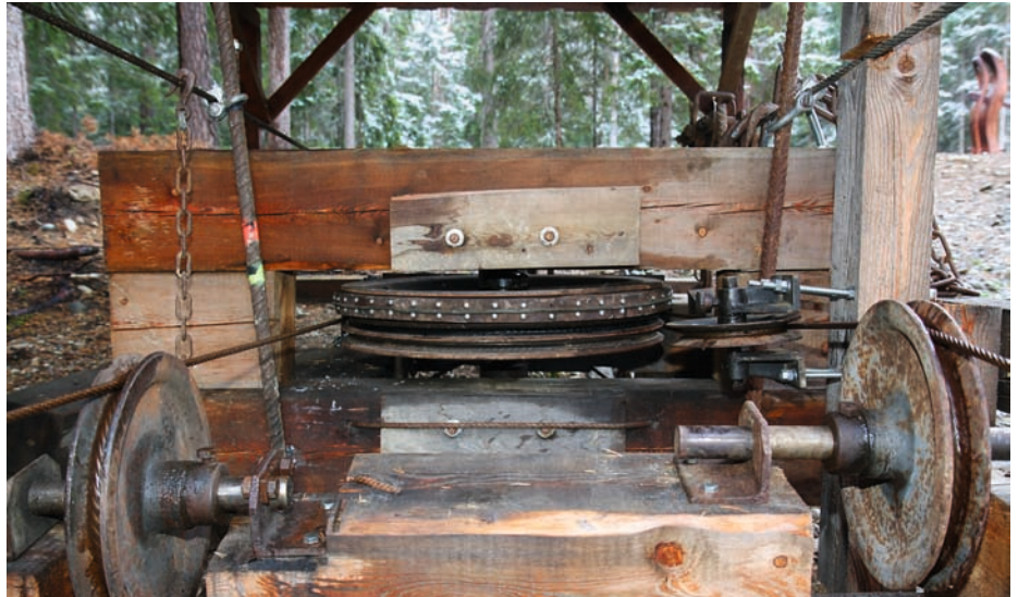
Die Bergstation: Ein endloses, verspleisstes Zugseil wird an der Berg- und an der Talstation über eine Umlenkrolle geführt. Das Lasttragseil (r.) und das Leertragseil (l.) werden fix an den Endstationen verankert.
