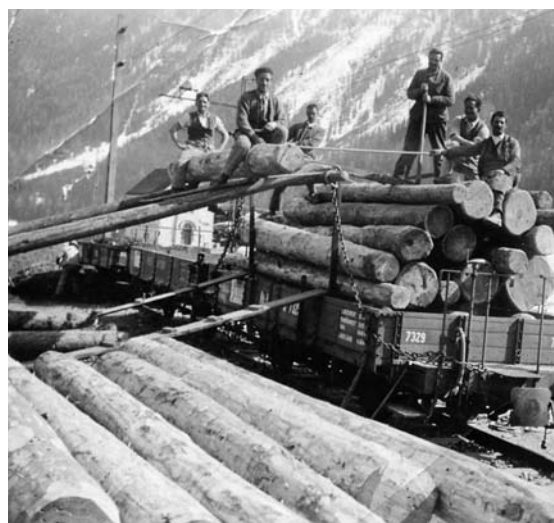
Die geschälten Baumstämme werden mittels Rampen von Hand auf die Wagen der Rhätischen Bahn RhB geladen (Ardez, ca. 1937).
