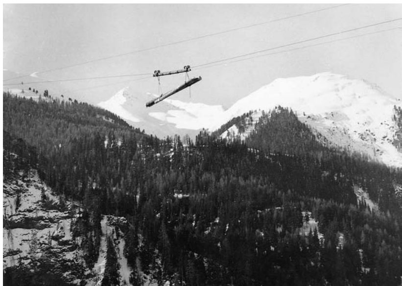
Valtellina-Seilbahn über die Ardezschlucht (ca. 1935): Durch die Hangabtriebskraft bewegt sich die Last auf dem Trageisil zu Tale.
