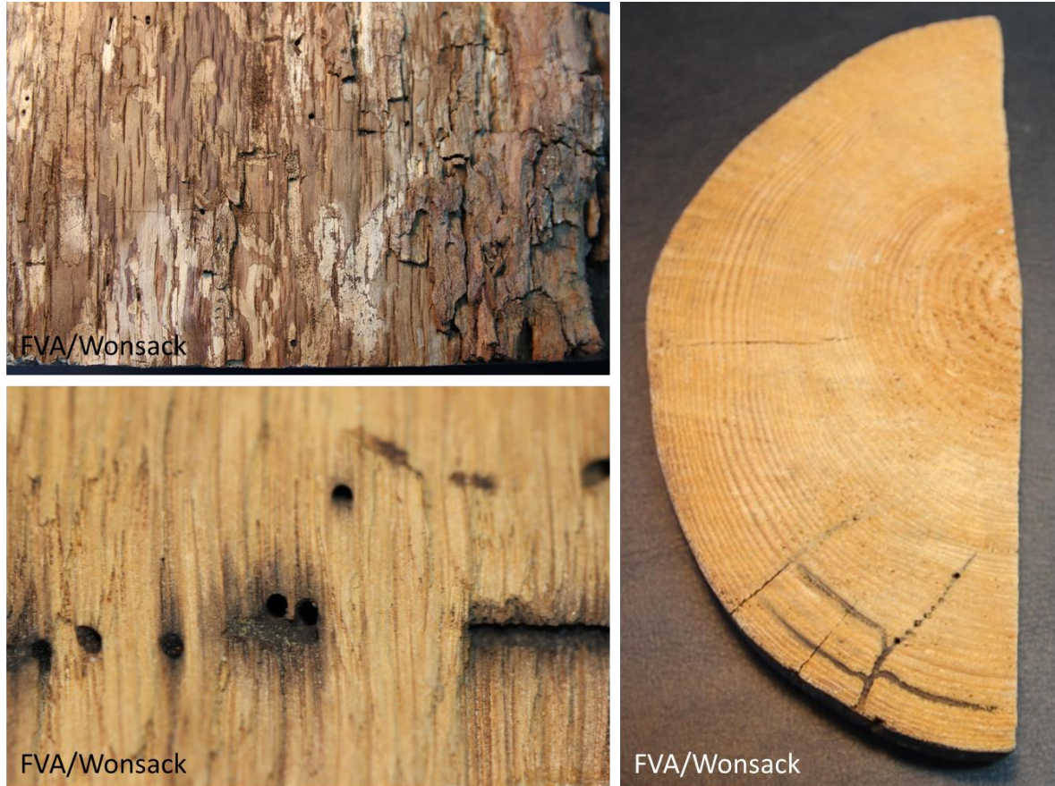
Abbildung 1: Schadbilder des Eichenholzbohrers mit Einbohrlöchern (o.l.), durch Ambrosiapilze dunkel gefärbte Gänge (u.l.) und typischer Gabelgang (r.)
